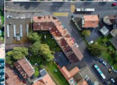
QUARTIER MUSS WEICHEN Der Tunnelbau braucht Platz. Das Haus von 1902, wo Nicole Zribi (siehe Text) wohnt, wird abgerissen.
